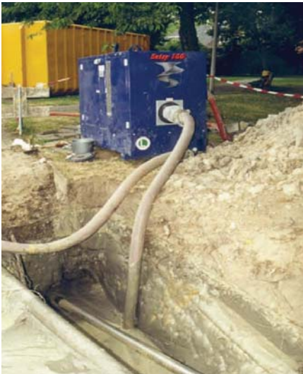
Pumpen von verschmutztem Betonit aus dem Bohrloch, während einer Horizontalbohrung.
