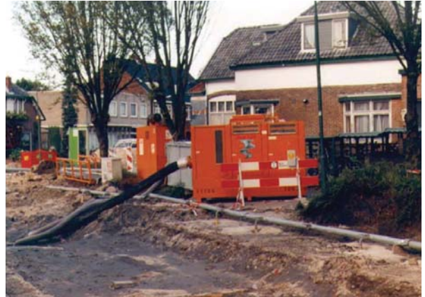
Pumpen von Rohabwasser außerhalb der eigentlichen Abwasserpumpanlage, während die neuen Rohrleitungen verlegt werden.
