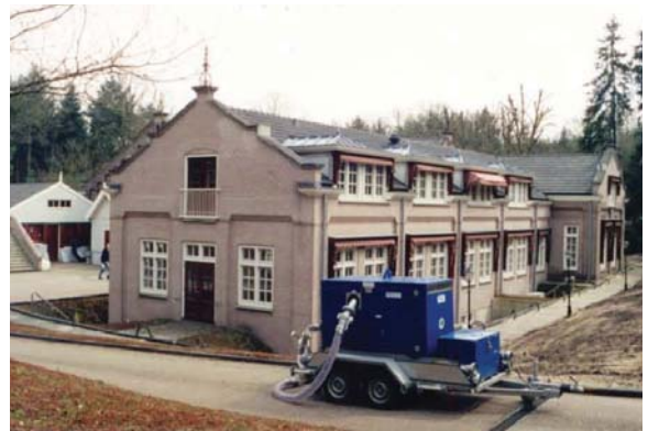
Absenken des Wasserspiegels unter einem Gebäude, während Renovierungsarbeiten.
