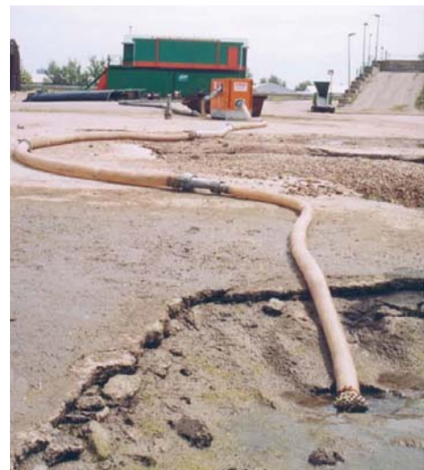
Freihalten einer Baustelle von Grund- und Oberflächenwasser.
